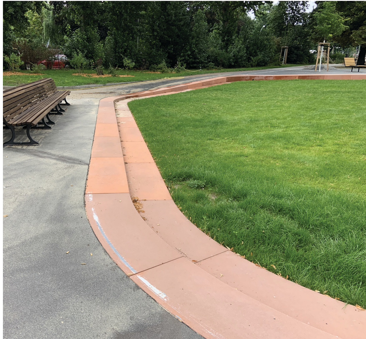
Abb. 59 - Rudolfplatz Berlin nach Umgestaltung als multifunktionale Fläche zur Rückhaltung und Versickerung von Niederschlag im Starkregenfall [1]
