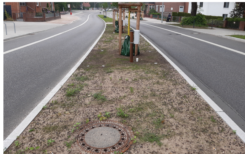
Abb. 15 - Hamburg-Bergedorf, Am Beckerskamp - Aushebung Baumgrube (o. li.), Verfüllung mit Schotter-Substrat-Gemisch (u. li.), Abschluss der Baumaßnahme (o. re.), Baumaßnahme nach 6 Monaten (u. re.) [7]
