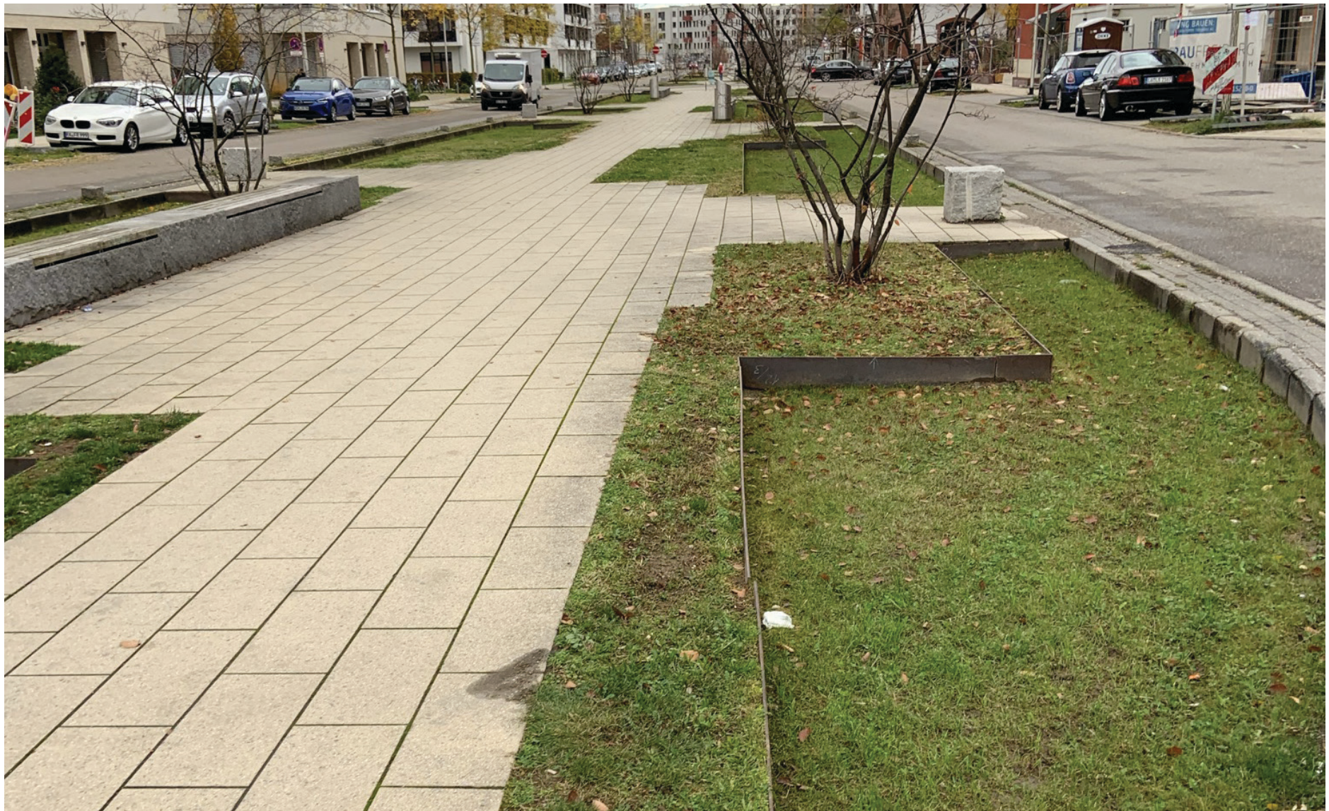
Abb. 72 - Senkbeet mit Cortenstahl Einfassung in Freiburg [8]
