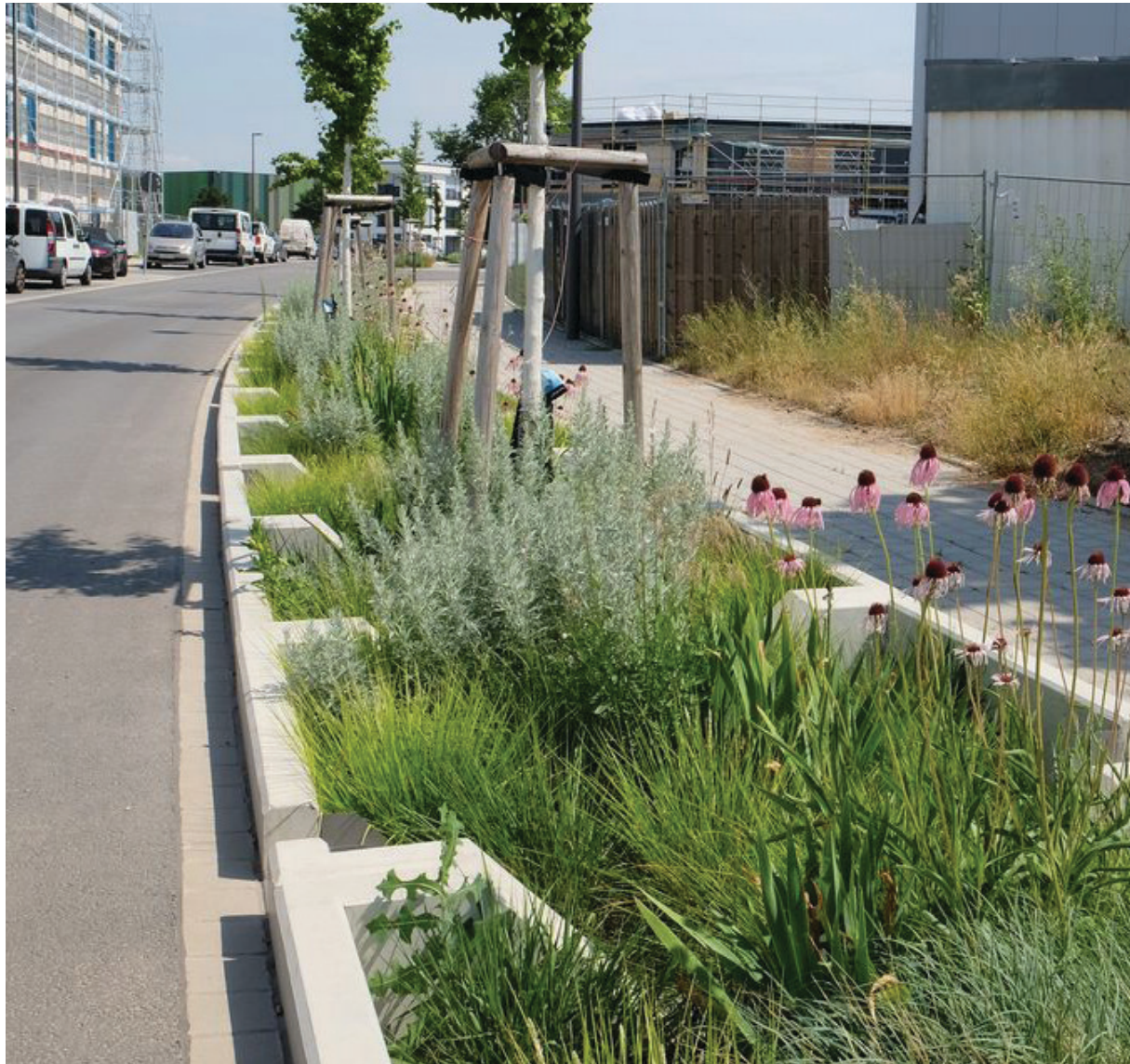
Abb. 45 - Tiefbeet mit Bäumen im Taylor Park, Mannheim [6]
