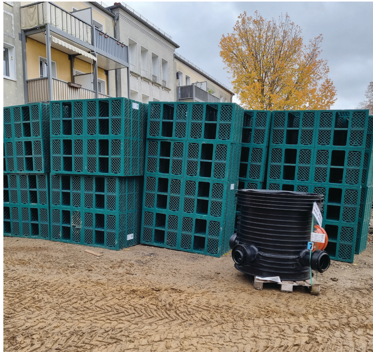
Abb. 42 - Kunststoffboxen (Rigolen) vor Einbau, Berlin Biesdorf [10]
