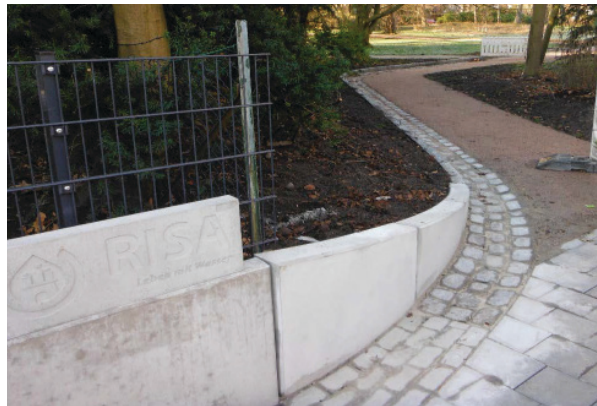
Abb. 87 - Änderung des Straßenprofils vom Dachprofil zum Querprofil (li.); Abfluss in Notwasserüberlauf / Notwasserweg (re.) [17]
