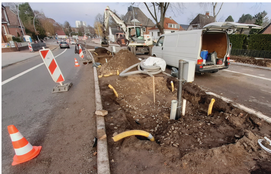
Abb. 15 - Hamburg-Bergedorf, Am Beckerskamp - Aushebung Baumgrube (o. li.), Verfüllung mit Schotter-Substrat-Gemisch (u. li.), Abschluss der Baumaßnahme (o. re.), Baumaßnahme nach 6 Monaten (u. re.) [7]
