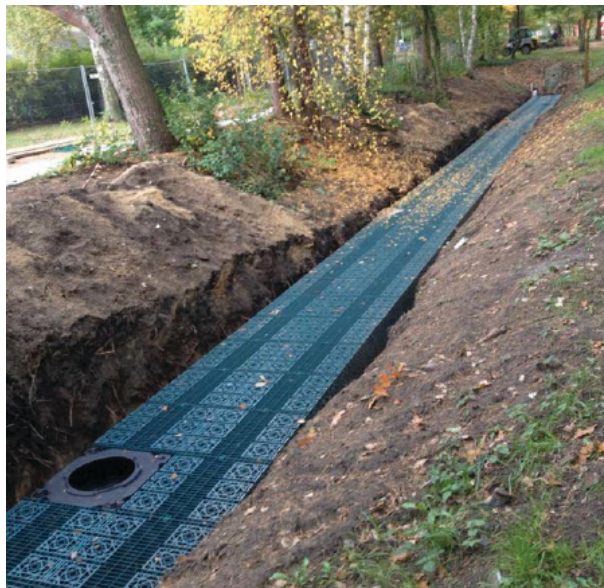
Abb. 86 - Einbau von Rigolen in den erweiterten Sickergraben (li.), Spielplatz mit Flutmulde (re.) [17]
