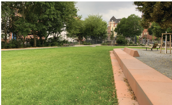
Abb. 59 - Rudolfplatz Berlin nach Umgestaltung als multifunktionale Fläche zur Rückhaltung und Versickerung von Niederschlag im Starkregenfall [1]
