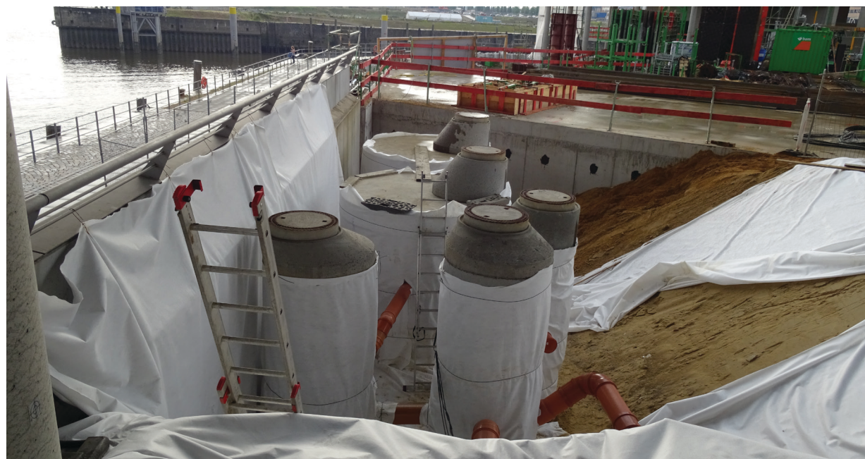
Abb. 51 - Einbau von Zisternen an der HafenCity Universität Hamburg [5]
