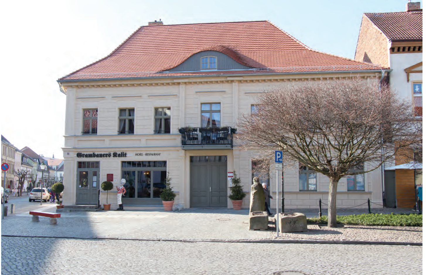
Stadtbildprägendes Gebäude erhalten: Haus Kalit in Angermünde nach Sanierung 2014
