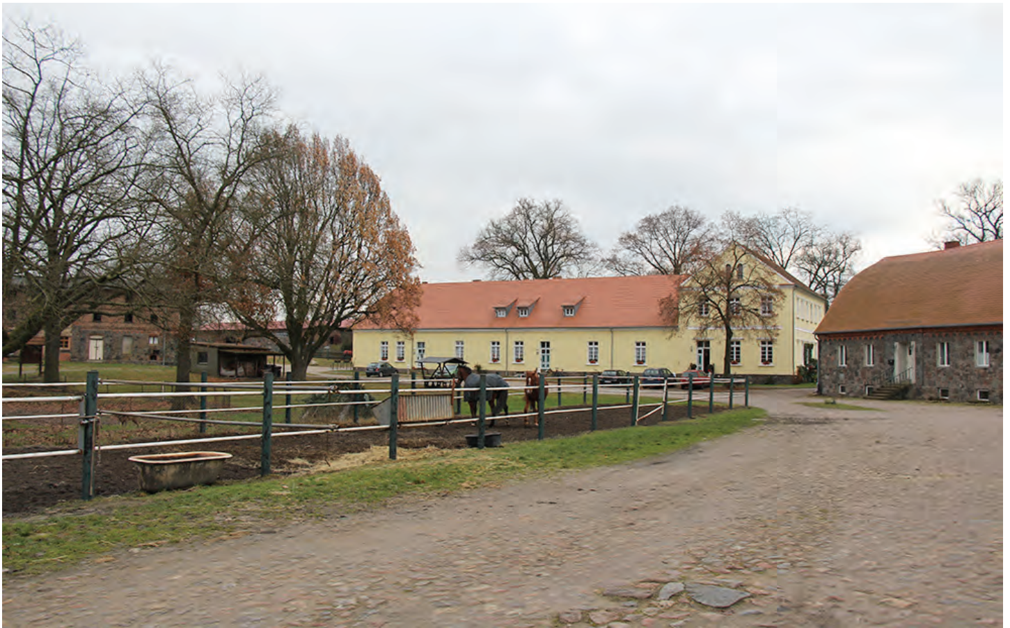
Gutshofanlage Behlendorf, der sogenannte Schinkelhof, mit saniertem Herrenhaus
