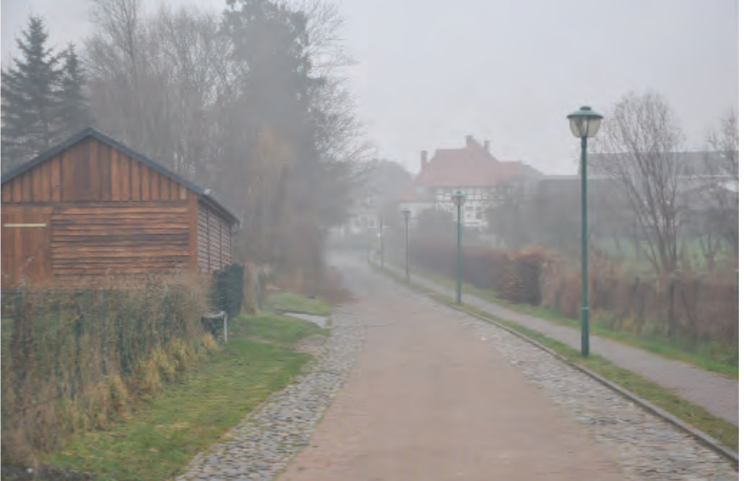
Mühlenweg nach Erneuerung in Boitzenburg
