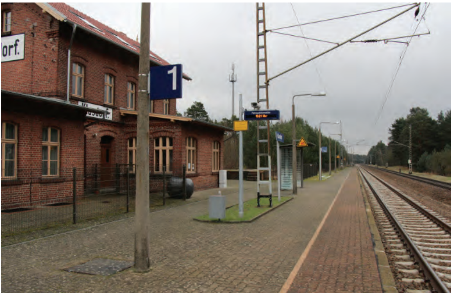
Bahnhof Klasdorf bei Glashütte
