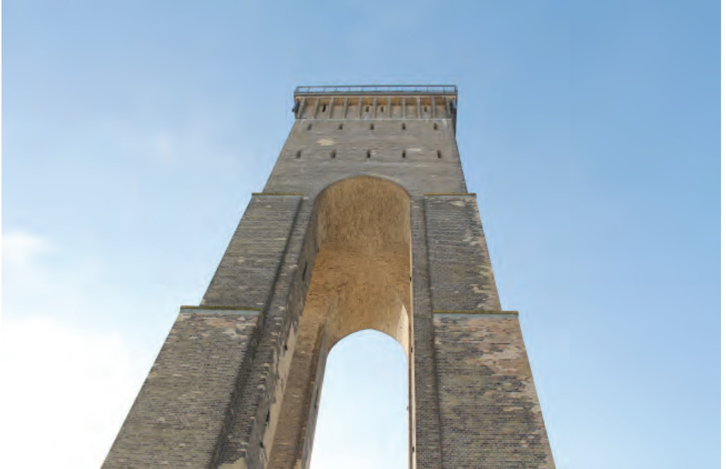
Wasserturm Messingsfabriksiedlung in Finow
