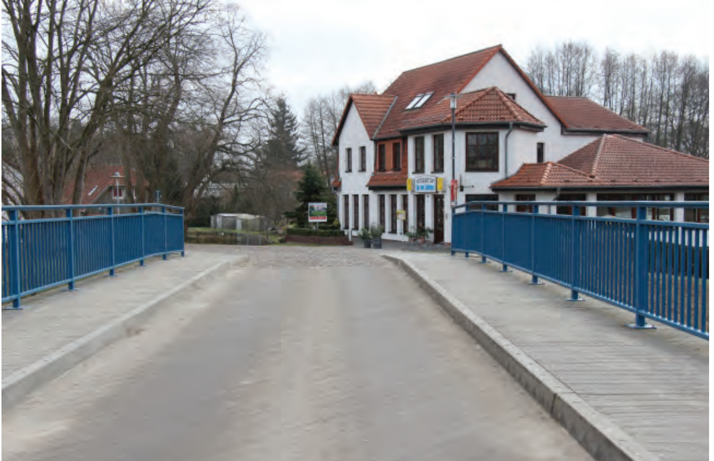
Erneuerte Brücke mit Holzbelag in Himmelpfort
