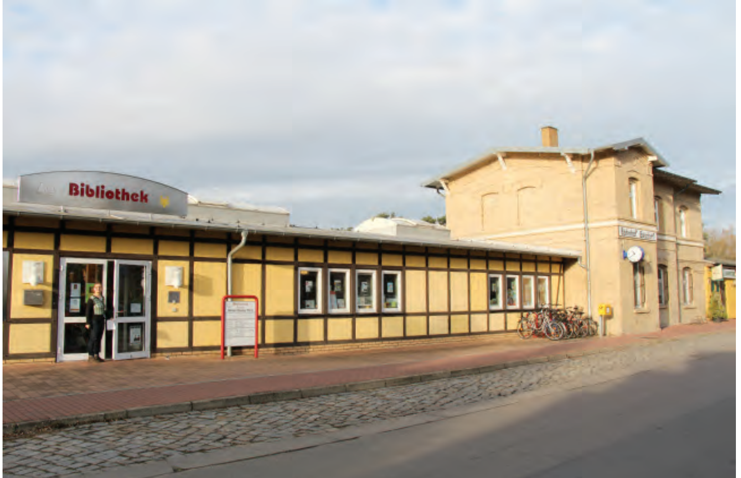
Bibliothek der Gemeinde Wandlitz im Bahnhofsgebäude
