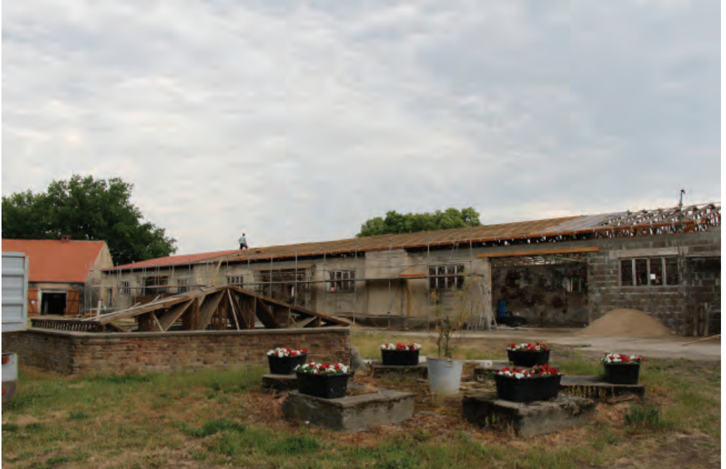
Gut Behlendorf, Dachsanierung des Stallgebäudes im Juni 2015
