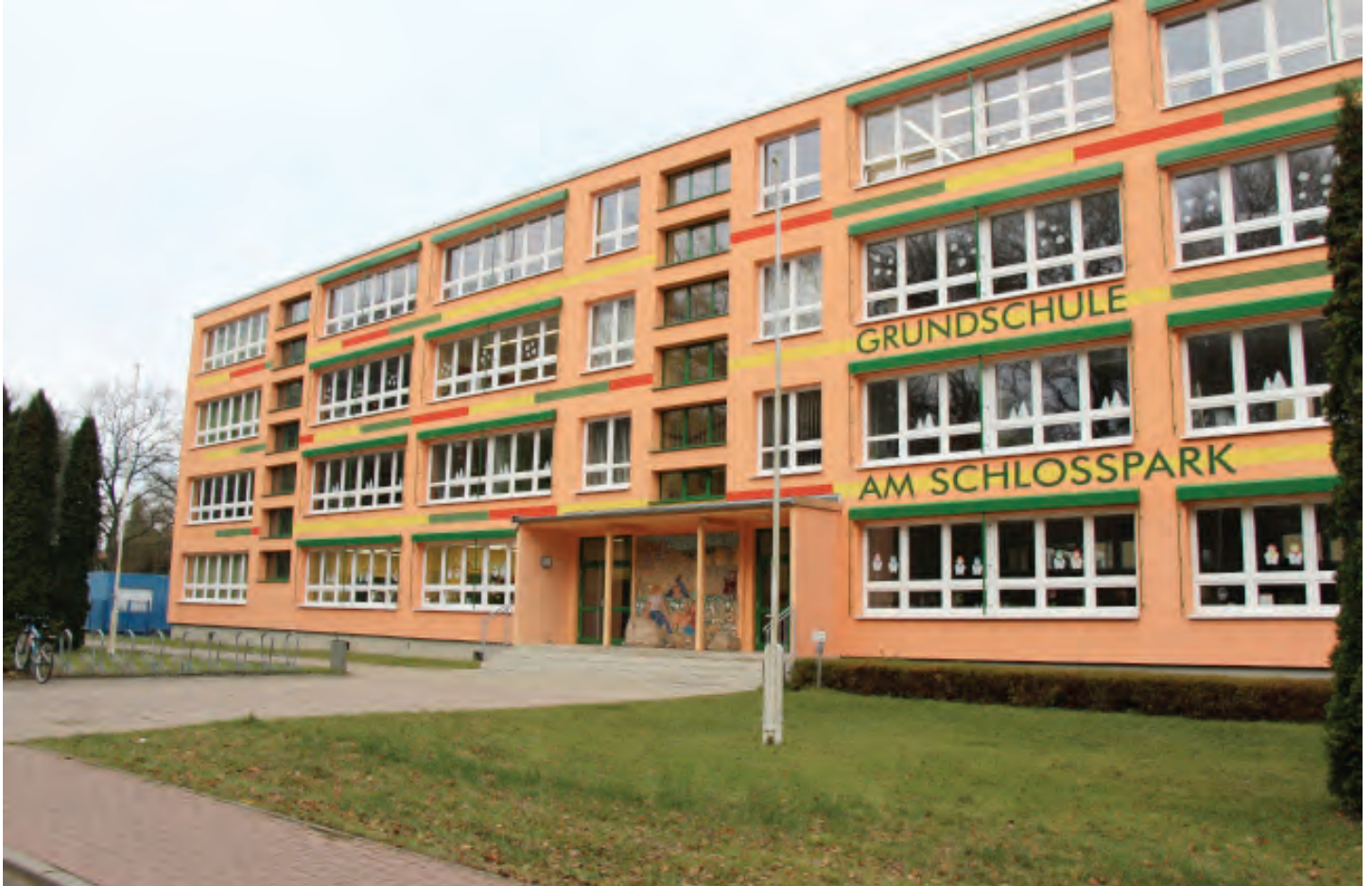
Grundschule nach Sanierung in Wiesenburg/Mark
