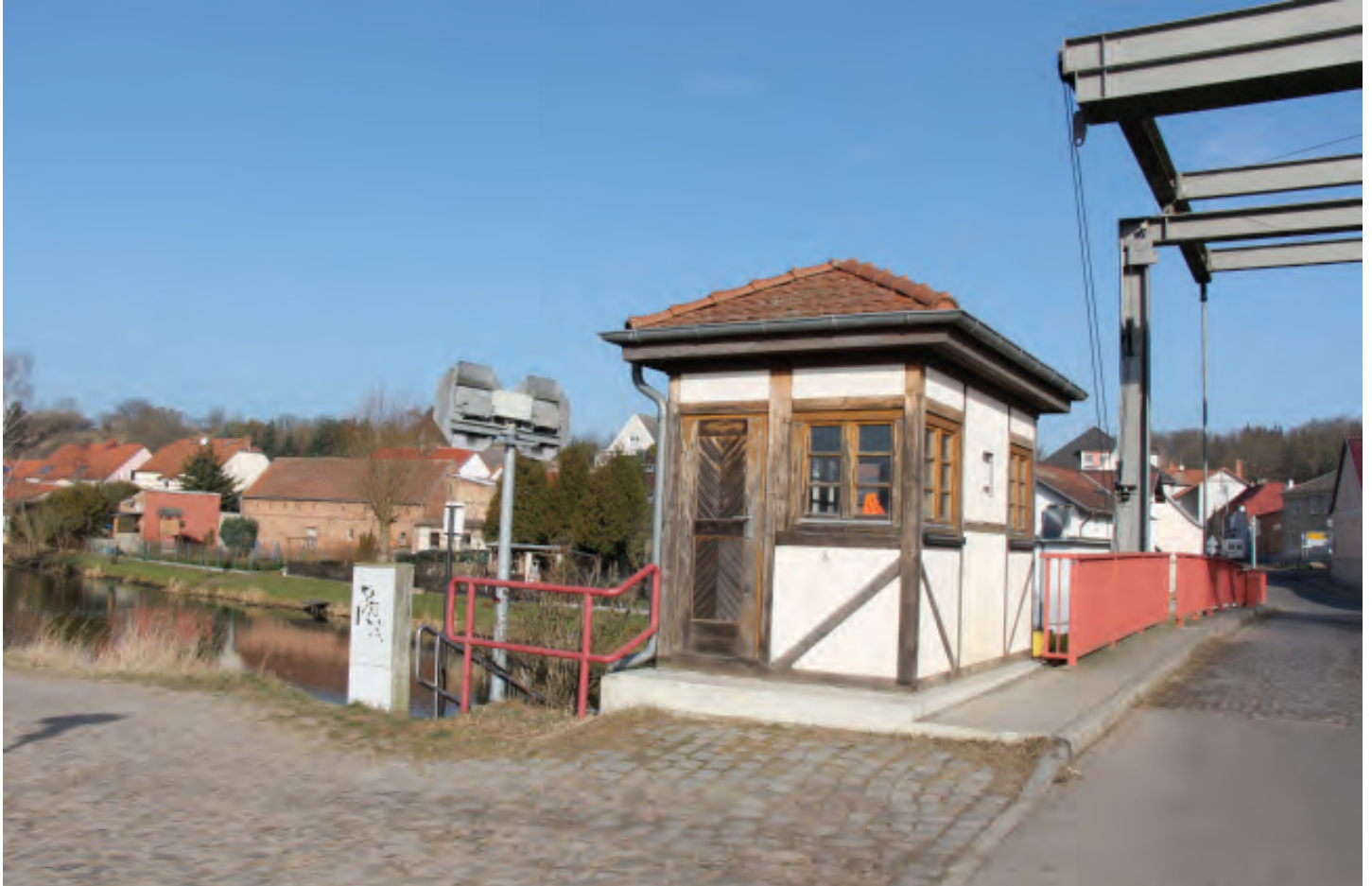
Brückenhaus in Niederfinow
