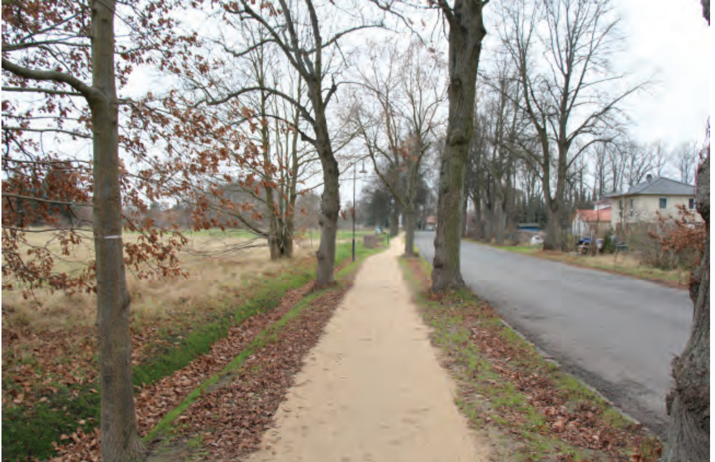
Ortsdurchfahrt mit Fuß- und Radweg in Wandlitz
