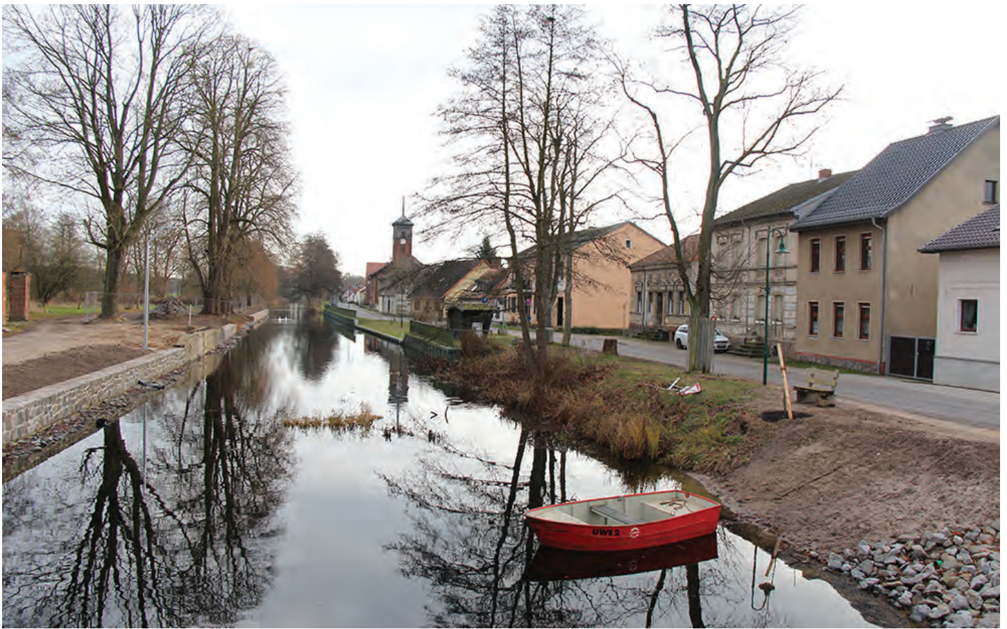
Langer Trödel nach Sanierungsarbeiten in Zerpenschleuse
