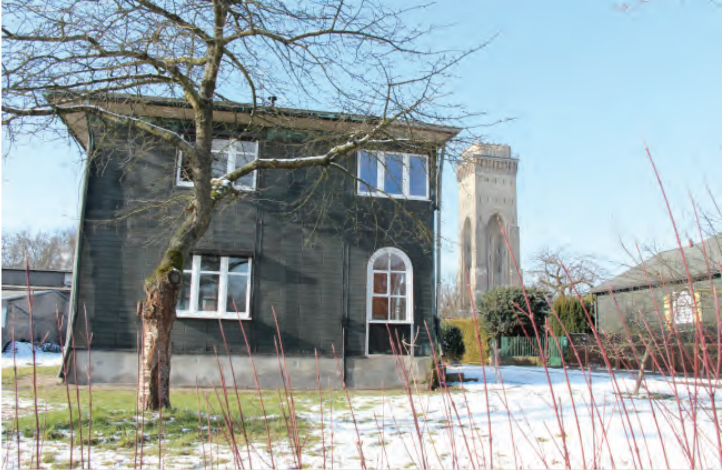
Musterhäuser mit Kupferblechverkleidung in Finow
