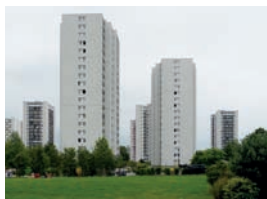
Die Wohnhäuser der Siedlung Saussaie
