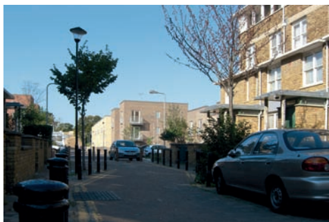
Verkehrsberuhigung und neue Vorzonen im sanierten Bereich
