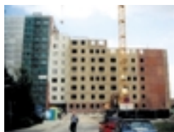
7 Demontage eines Hochhauses und Wiederverwendung der Platten zum Bau von Stadtviellen
