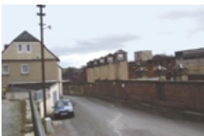
Der zur Zeit noch verrohrte Raumbach an der Grundstücksgrenze des Areals (Bild rechts)
