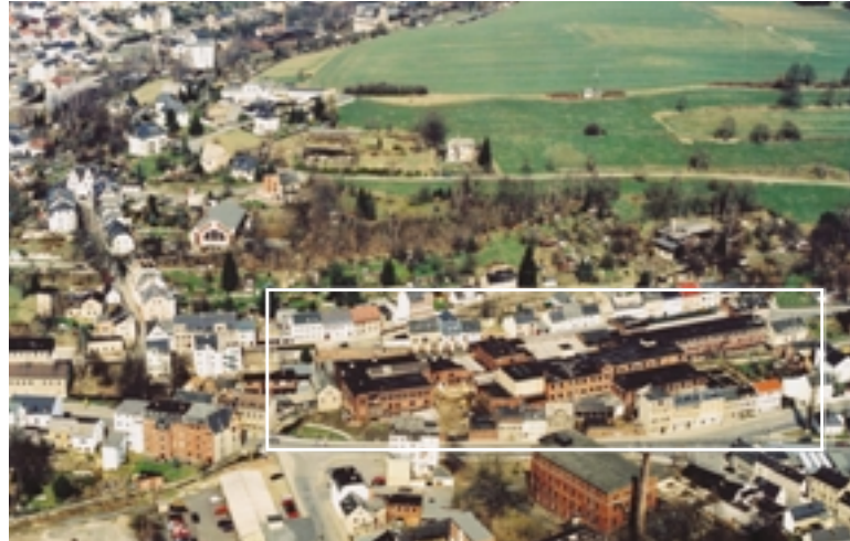
Der südöstliche Teil der Altstadt mit dem markierten Areal des ehemaligen Industriebetriebs „VEB Vogtlandstoffe“
