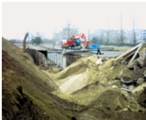
Entnahme der Sammelkollektoren im 1. Bauabschnitt der geplanten Waldfläche
