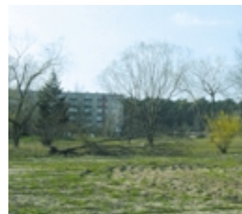
Flächenabriss im Wohngebiet „Am Waldrand“ - großflächige Renaturierung und geplante Aufforstung der Abrissflächen
