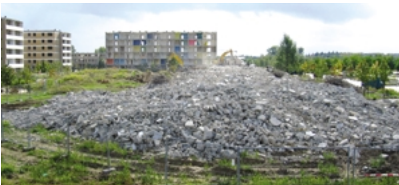
Der Blick nach Süden über die abgerissene westliche Flanke des WK VII Süd
