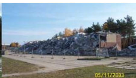
Während des Abrisses 2003
