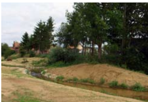
Baustelle Biotopverbund westlich der Bahnanlage (Foto: bgmr Landschaftsarchitekten)
