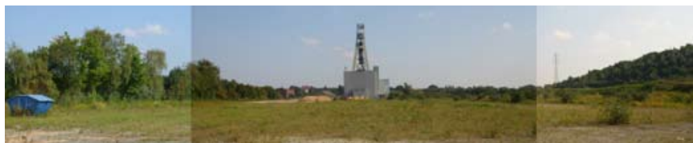
Gelände des zukünftigen Biomasseparks Hugo mit Schacht II (Fotomontage: bgmr Landschaftsarchitekten)
