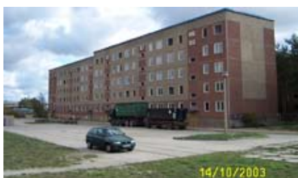
Scholl-Strasse 61-69 vor dem Abriss 2003 (Fotos: Stadt Weisswasser)
