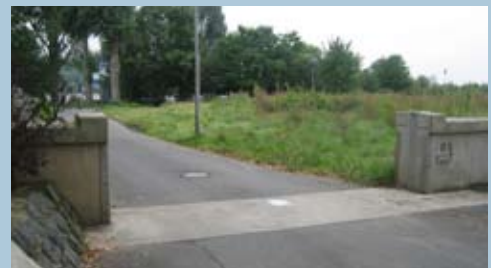
Technischer Hochwasserschutz am Rhein (Foto: bgmr Landschaftsarchitekten)
