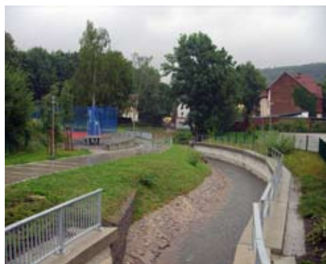
Unterer Bachlauf, baulich gefasst (Foto: bgmr Landschaftsarchitekten)
