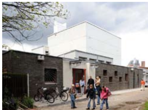
Im Düsseldorfer Stadtteil Garrath wurde in den Räumen eines kirchlichen Gemeindezentrums ein Mehrgenerationenhaus aufgebaut
