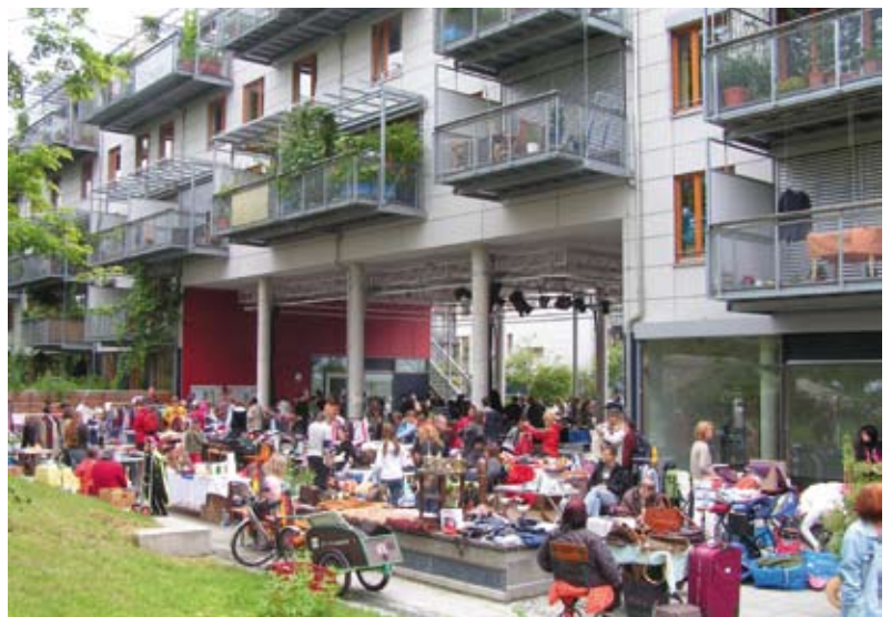
Gemeinschaftseinrichtungen tragen dazu bei, Image und Identität der Quartiere zu stärken (München)
