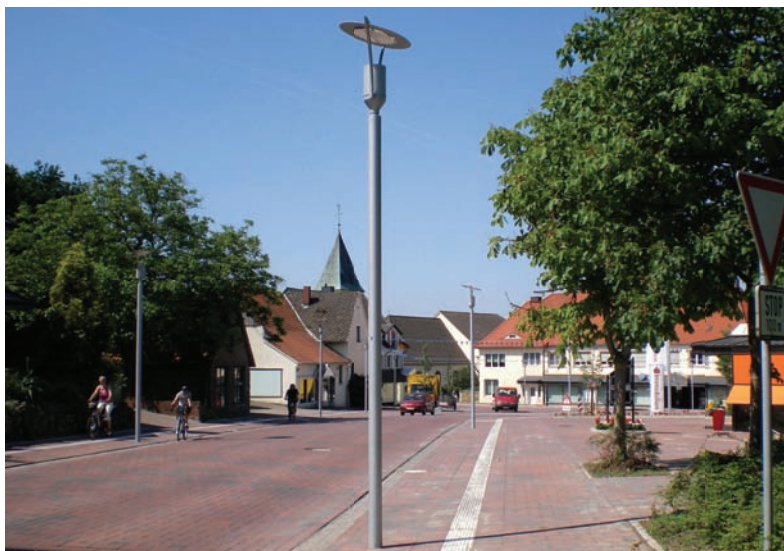
Standleuchten markieren die Fahrgasse und sorgen durch ihr indirektes Licht für eine atmosphärische Ausleuchtung des Platzraumes. Durch die technische Umrüstung konnte der bisherige Energieverbrauch um zwei Drittel reduziert werden. (Foto: bgmr)
