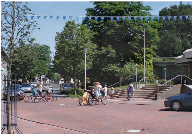
Umgestaltete Einmündung an der Kreuzung Bremer/Leverner Straße (Foto: bgmr)
