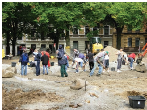
Mitmach-Baustelle (Foto: Rolf Martin)
